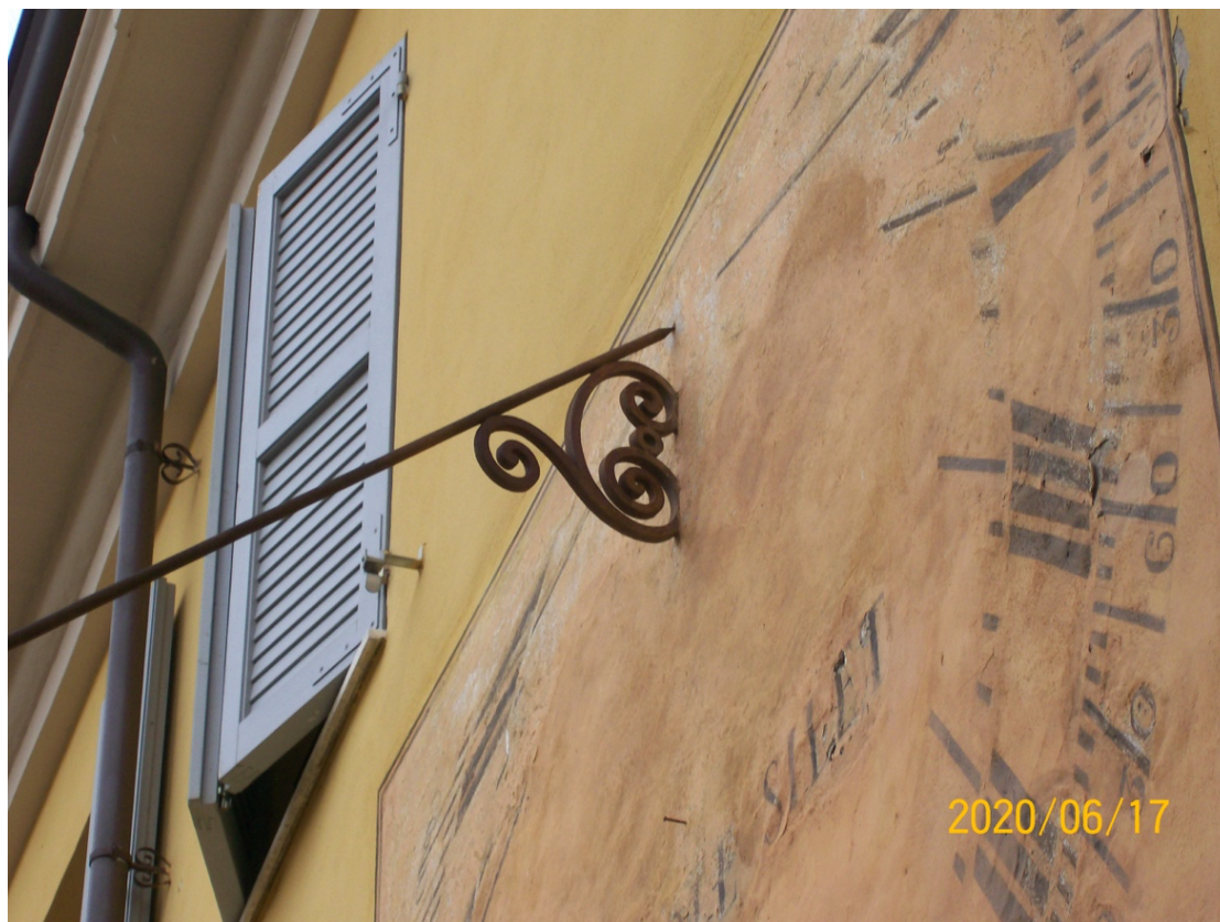
Fig. 3 – Lo stilo è fissato con due ribattini su un supporto in assetto polare.
