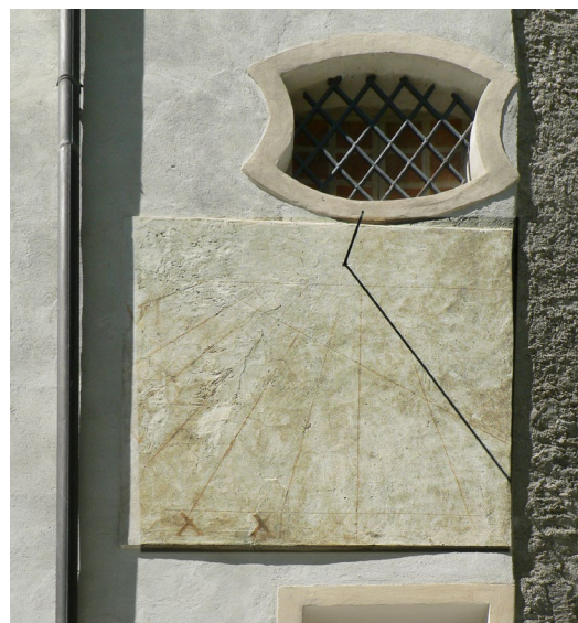
Fig. 5 – Il quadrante a ora francese declinate a Est, ( IT1086 ), dopo il restauro [rif. 4].
