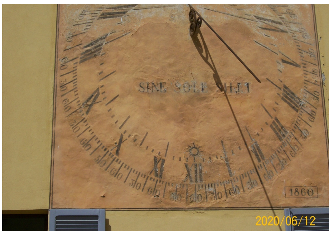
Fig. 2 – Lo stato attuale dell'orologio solare, documentato in una immagine del 2020, dove si può notare il maldestro restauro operato nel 2004. Osservare sulla sinistra del quadrante come le sequenze dei minuti 30 e 60 sono spesso riferite alle demarcazioni dei quarti d'ora, e le ore intere talvolta associate a tacche dei 5 minuti.
