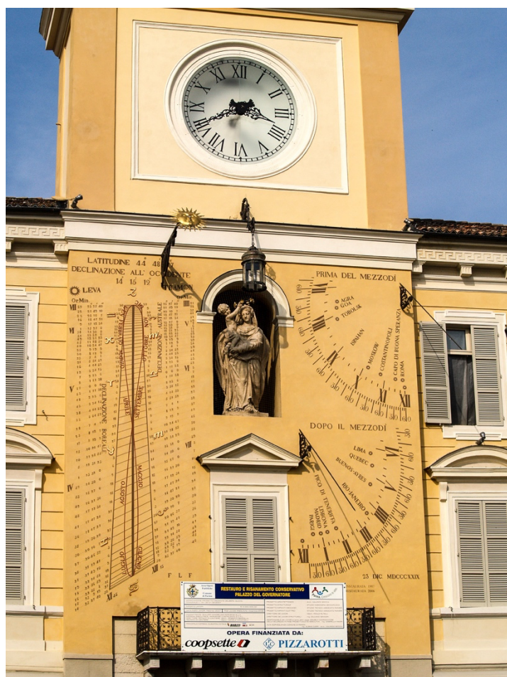
Figura 5 – Il complesso gnomonico sulla facciata del palazzo del Governatore in piazza Garibaldi a Parma, come appare in seguito al restauro del 2006, sempre eseguito con la mia consulenza gnomonica.
